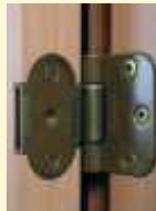
typ F FISKARS 6540N používaný pouze u pevných dřevěných zárubní
