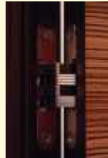
závěs krytý typ E používaný pouze u pevné dřevěné zárubně
