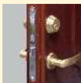
standardní zámek s cylindrickou vložkou
